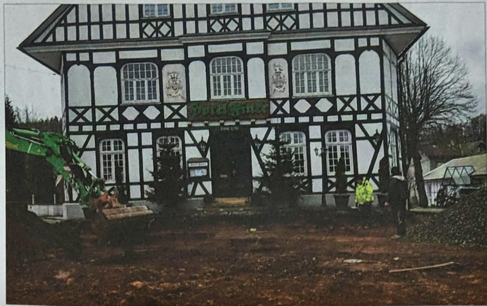
Die Arbeiten zum Ausbau der Ferndorfer Ortsdurchfahrt sind vor Kurzem angelaufen. Gestern dann wurde überraschend ein Stück Heimatgeschichte freigeblüdet: Vor Hotel Finke wurde ein mit Wasser gefüllter Brunnen entdeckt. Fotos: Stadt
